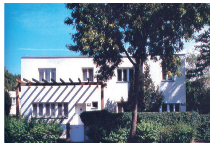
Werkbundsiedlung, Haus Architekt Ernst Lichtblau
